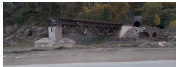
Bild: Weggespülte Eisenbahnbrücke im Ahrtal, © A. Henze
