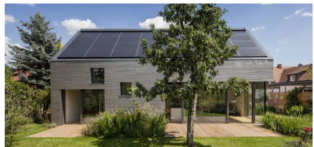
Bild: PV-Indach im Plusenergiehaus, Freising, ©Michael Heinrich
